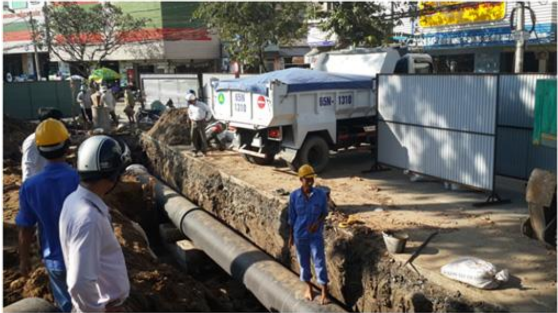
Hình 3: Hình ảnh thi công của Công ty Cổ phần Cấp thoát nước Cần Thơ
